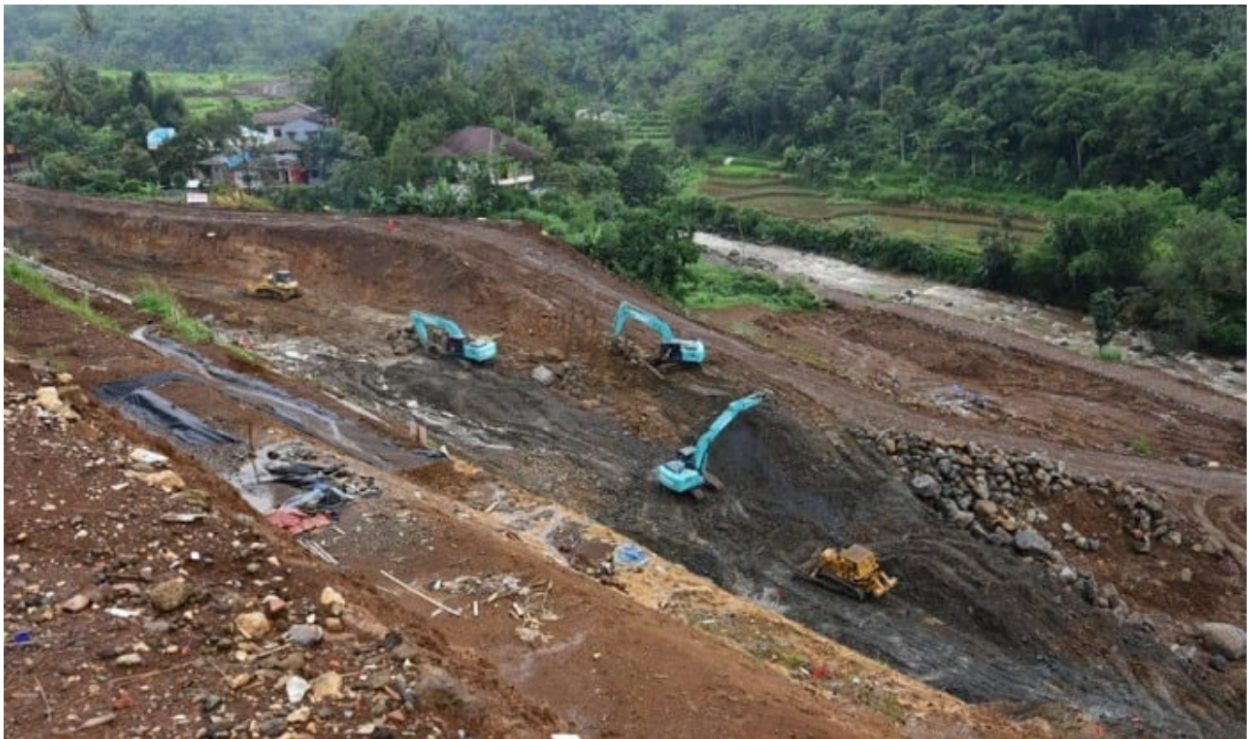
Progres pembangunan Bendungan Ciawi.
